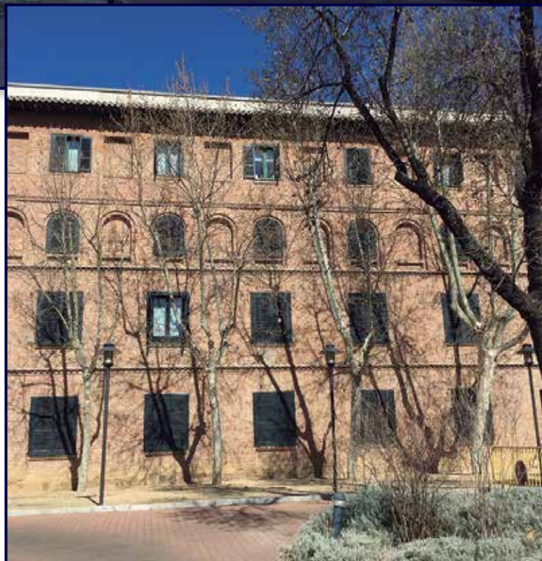
Fachada del edificio.
