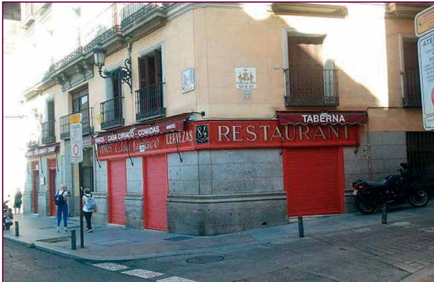
Fig.7. Imagen de la portada de la taberna que permanece cerrada durante la realización de las obras, septiembre 2018.
