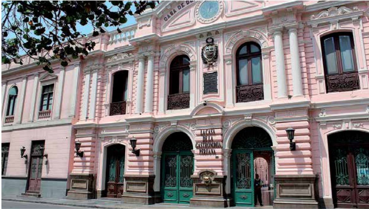
La antigua Casa de Correos y Telégrafos ocupa la cuadra siguiente al Palacio de Gobierno.
