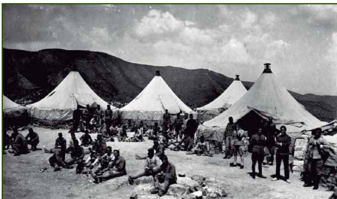
Imagen en la que se aprecia el interior de una de las 135 posiciones.
